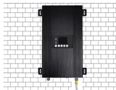
Fissaggio a muro dell'amplificatore eseguito
